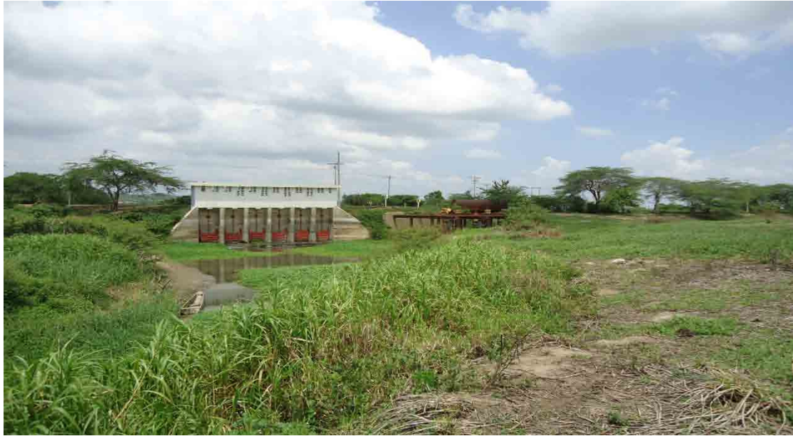
Figura 5.1. Compuertas de Villa Rosa, ubicadas a 180 metros del Canal del Dique (K30)
