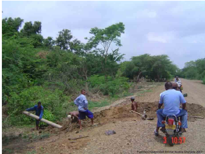
Figura 2.15. Instalación de tuberías en el cuerpo del dique carretable
