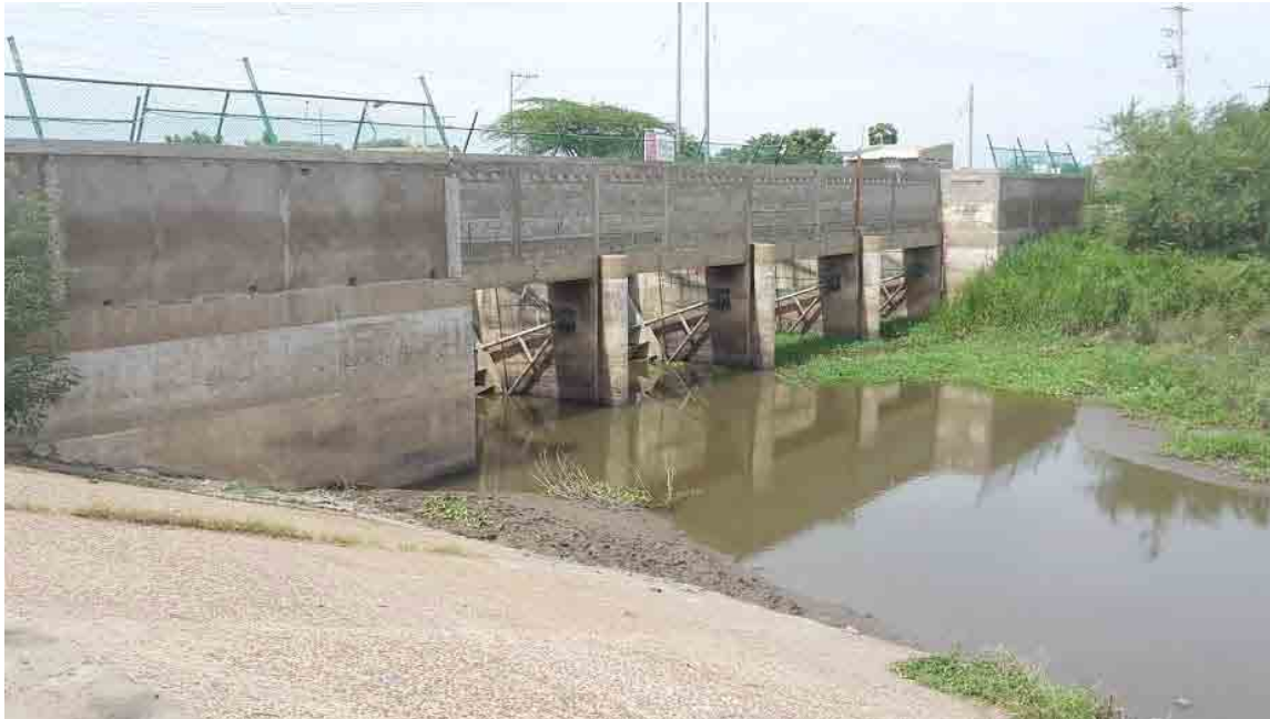
Figura 5.2. Compuertas en El Limón, ubicadas a 40 m del Canal del Dique (K25)
